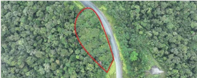
Exitosa rehabilitación interna en Cobre Panamá
