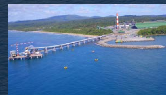
Puerto Internacional Punta Rincón y planta de energía
